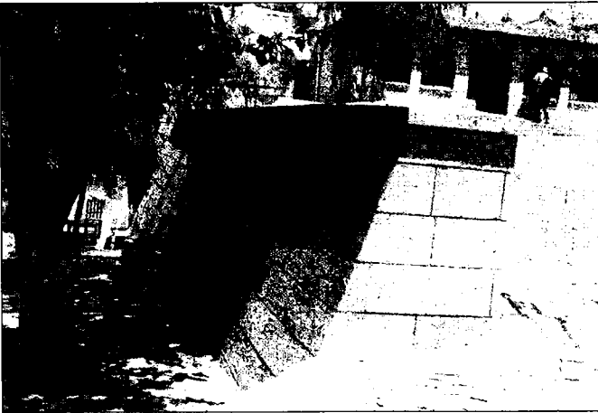
Resim 15: Göreme Açık hava Müzesi, çevre düzenlemesi kapsamında yenilene ihata duvarı
